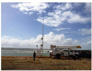
Se le cambio el poste que sostiene el anenometro y los paneles solares
